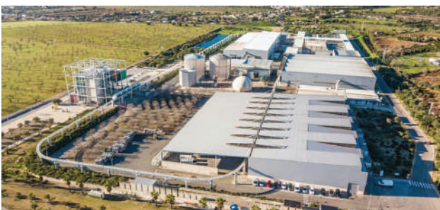
Instal·lacions de TIRME.
